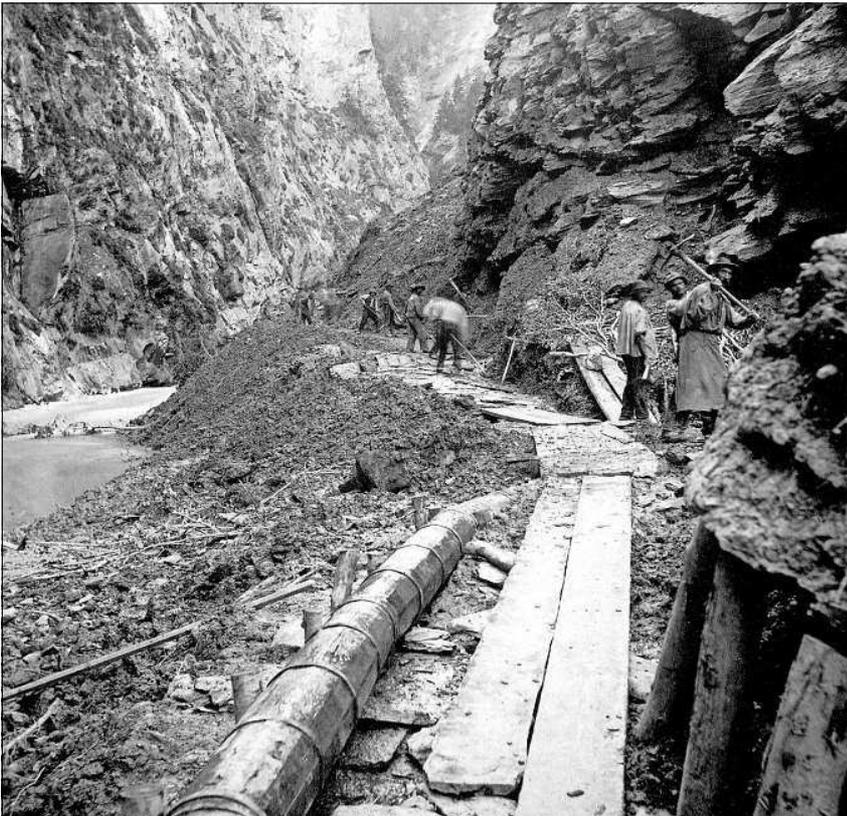
*Teuchelverlegung der Thermalwasserleitung.*
